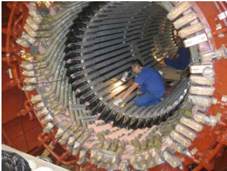
Figura 2.26. Núcleo estator [ https://www.swe.siemens.com/spain/web/es/energy/com_energy/proyectos/Pages/proyecto_almaraz.aspx ].
