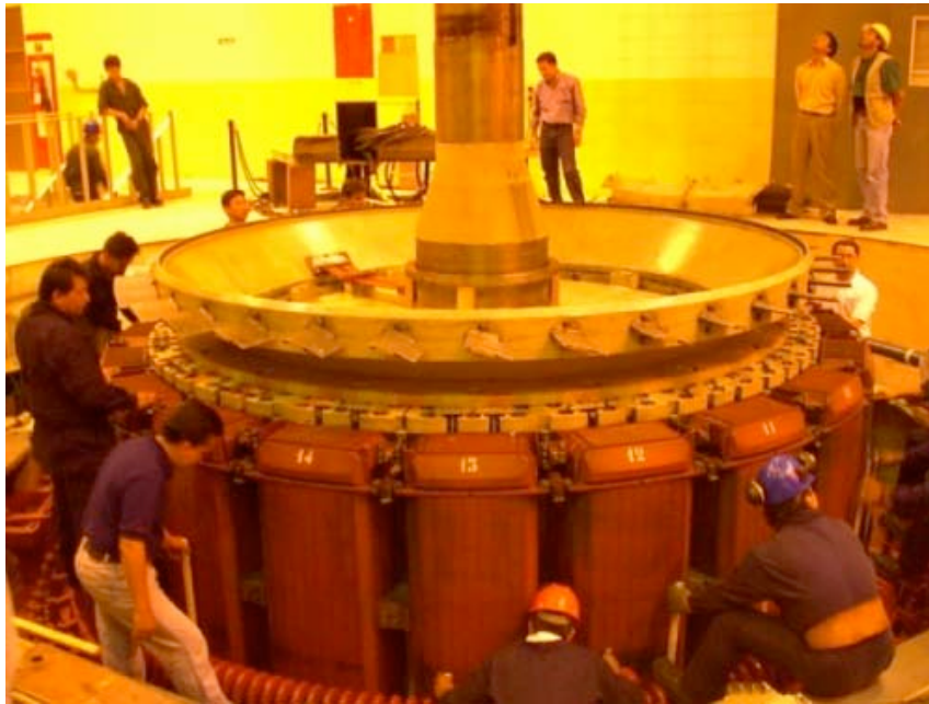
Figura 2.31. Extracción de un rotor [ http://grupos.emagister.com/imagen/extraccion_de_un_rotor_de_generator_de_100_megawattios/25514-5147451 ]
