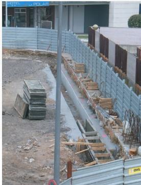
«Ejecución del muro pantalla continuo del Depósito de Tormantas de Gijón».
