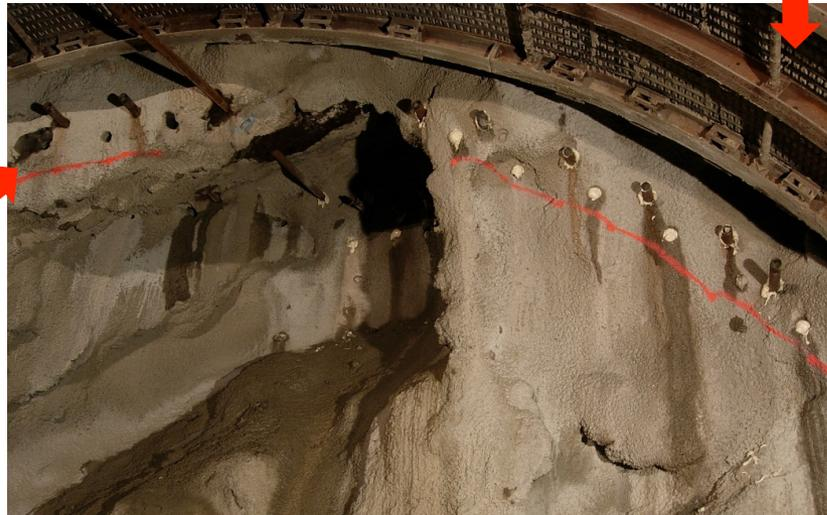
«Paraguas de micropilotes en el túnel de El Guincho (Tenerife)».
