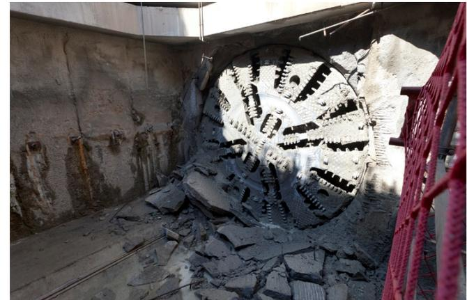
«Perforación del túnel de Montcada i Reixac (Barcelona)».
