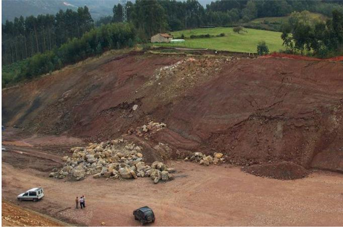
Deslizamiento en talud de desmonte.
