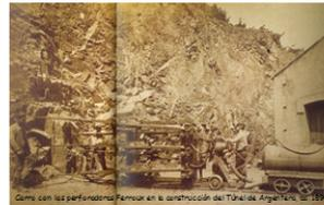
Como con las perforadoras Ferrussol en la construcción del Túnel de Argenteau, en 1870
