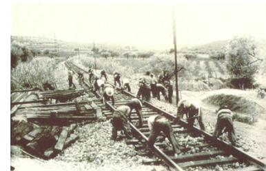
Montaje de la vía sobre la plataforma ferroviaria
