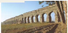
Conducciones elevadas (acueductos)
