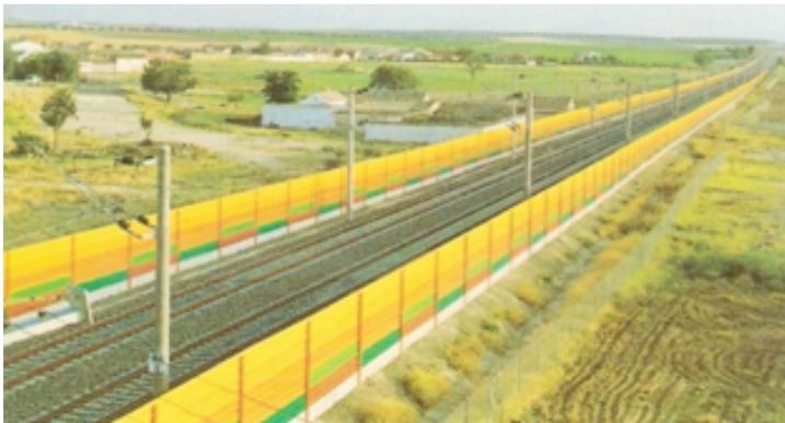
**Pantallas acústicas:** son barreras constituidas por elementos de pared, verticales o inclinadas. Pueden estar constituidas por diferentes materiales: hormigón, madera, vidrio, materiales plásticos, cerámicos...
