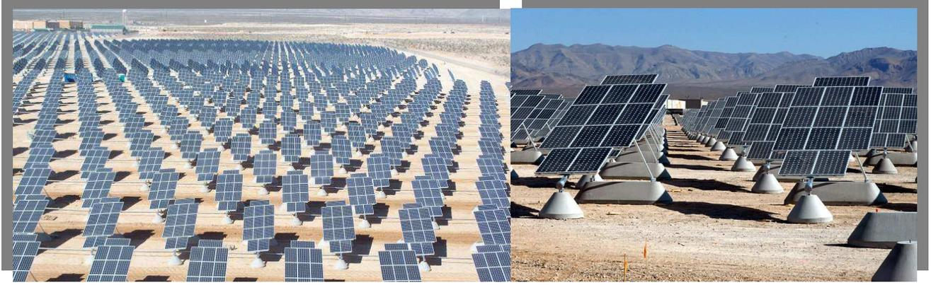
La mayoría de los captadores solares instalados son captadores solares planos, los cuales tienen una geometría que se muestra en la imagen de la derecha, compuesta por 11 elementos cuadrados y uno rectangular, apoyados sobre una base de hormigón troncocónica a través de un elemento cilíndrico metálico.
