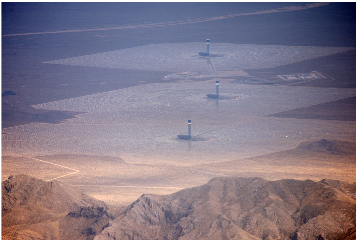
Figura 7.6. Instalación solar de concentración en Ivanpah (USA). Fuente: Wikimedia. Licencia: CC-BY-SA 4.0. http://bit.ly/2jdz14r
