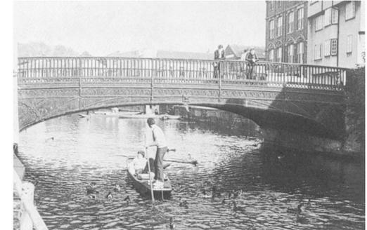
Magdalen Bridge, construido en 1823 en el lugar del antiguo puente Saxon sobre el Cam. El actual puente de fundición soportaba, hasta hace muy poco, cargas muy superiores a las previstas por los diseñadores. Por fortuna, el puente ha sido bien restaurado recientemente.
