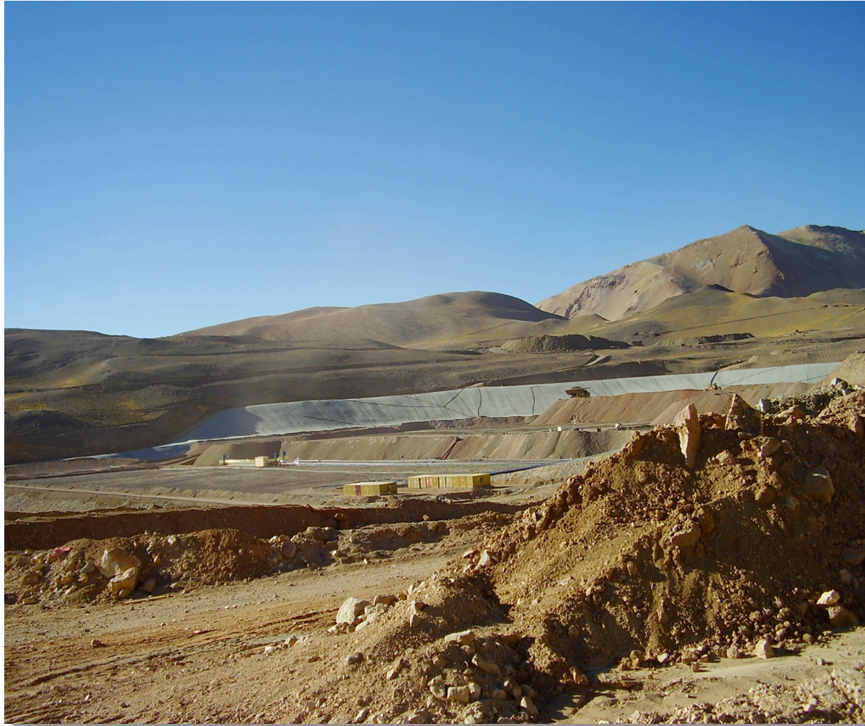
Dique de lixiviación en la Mina Veladero (San Juan - Argentina)
