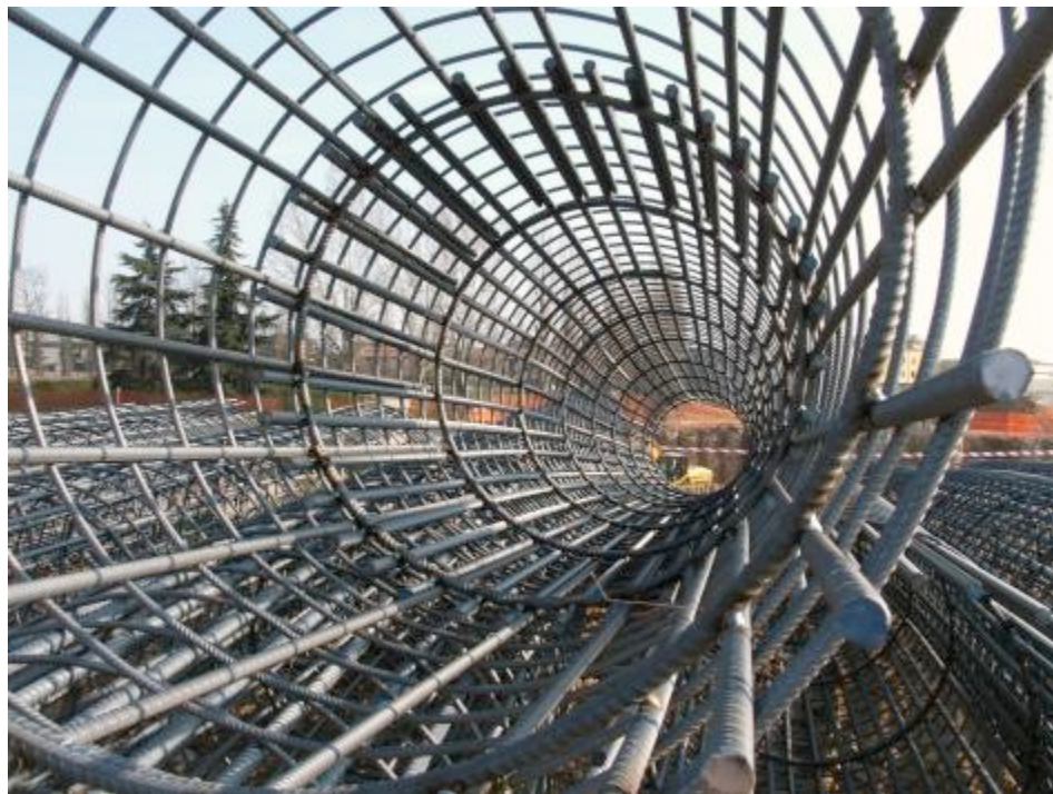
Armadura para un pilote de sección circular
