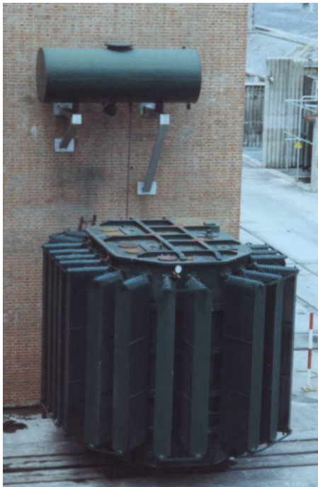
Fig. 5.4: Transformadores en baño de aceite
