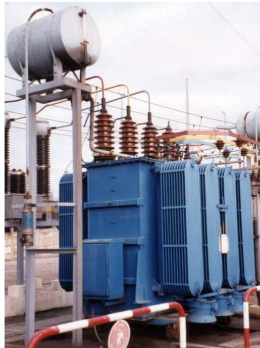
Fig. 5.4: Transformadores en baño de aceite
