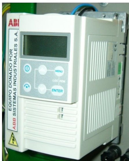
Fig. 6.21: Variador o convertidor de frecuencias
