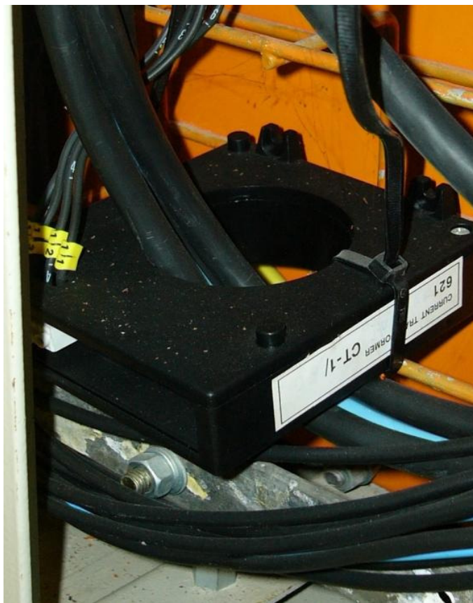
Fig. 3.6: Transformador diferencial
