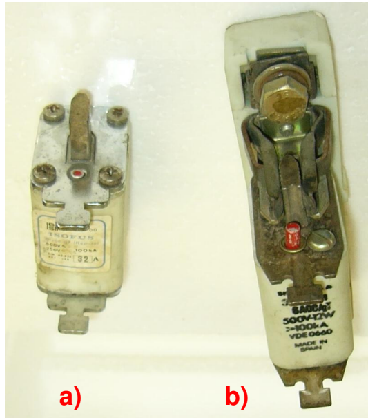
Fig. 3.13: Fusibles de cuchillas (NH).
