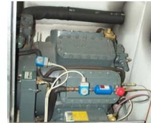
La capacidad se puede regular si se puede descargar (válvula de admisión abierta) alguno de los cilindros del compresor; pero el rendimiento no se mantiene
