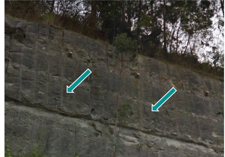
Talud ejecutado mediante voladura de precorte (Autovía E70).
