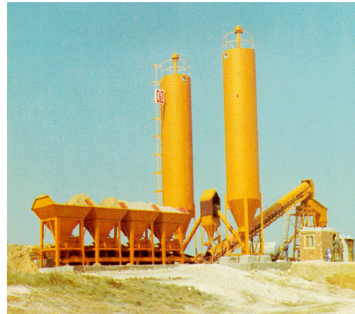
Planta fija de grava cemento para una producción de 250 t/h.
