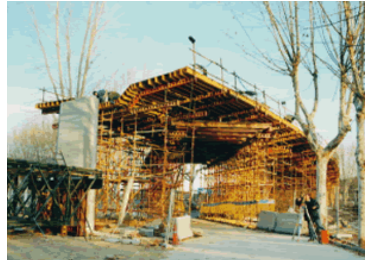
Ejemplos de encofrado plano y curvo (ala de gaviota) (RDM).
