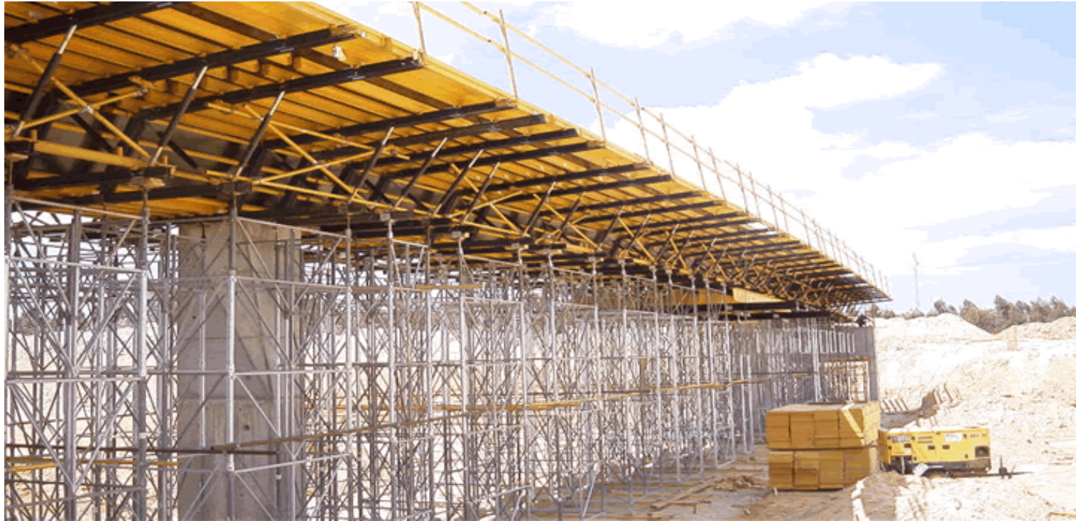
Encofrado de tablero (ULMA).
