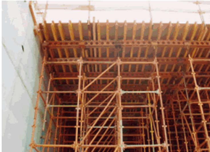
Ejemplos de encofrado plano y curvo (ala de gaviota) (RDM).
