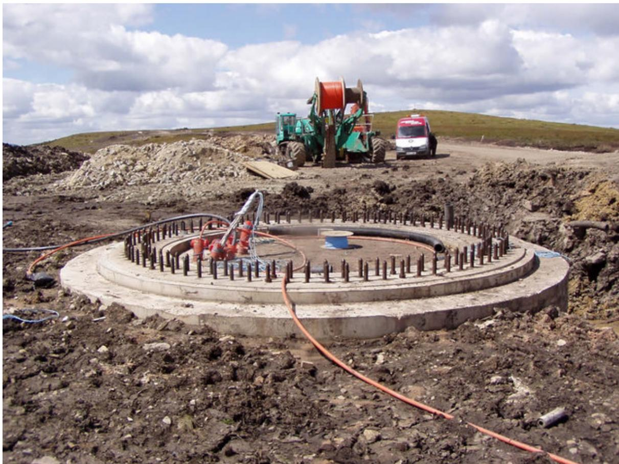
**Figura 37.** Cimentación de un aerogenerador *onshore*. Fuente: Wikimedia. Licencia: CC BY-SA 2.0. <http://bit.ly/2mLQ6nZ>
