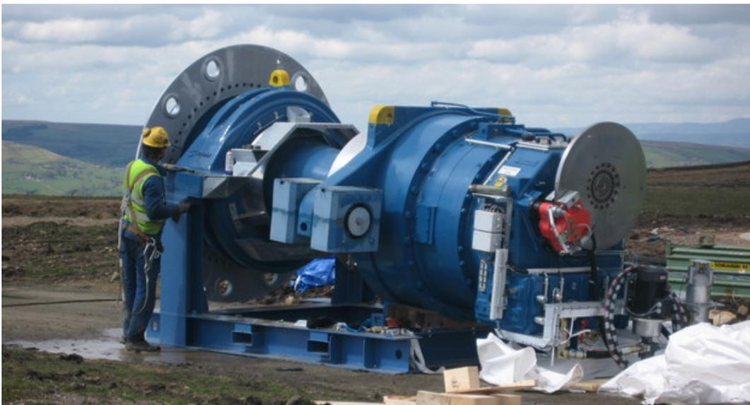
**Figura 49.** Detalle del ensamblado del sistema de frenado (y caja multiplicadora) de un aerogenerador modelo Nordex N80 (altura de torre: 60 m; longitud de pala: 40 m). Fuente: Paul Anderson (CC BY-SA 2.0). <http://bit.ly/2ES1HbK>
