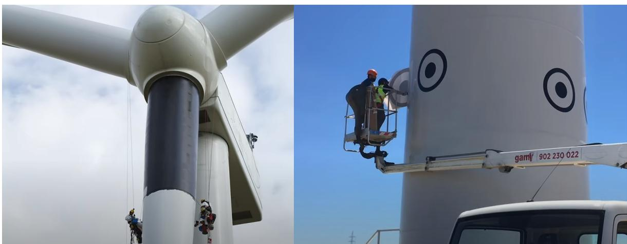
**Figura 8.** Pintado y uso de vinilos en aerogeneradores para disminuir los casos de muertes. Fuente: <https://bit.ly/3lWn2c8>. Licencia: YouTube Estándar.
