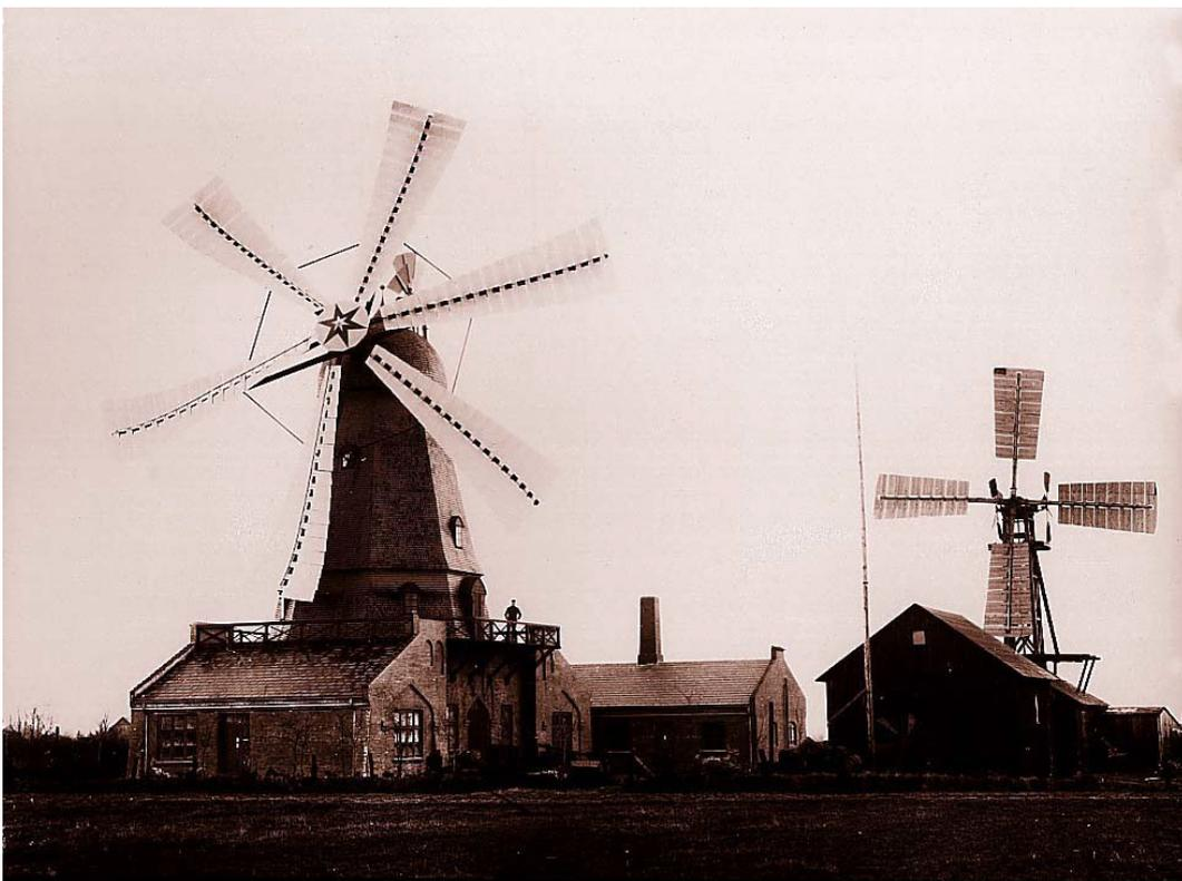
**Figura 2.** Imagen de 1897 de dos aerogeneradores de prueba de Poul la Cour en el instituto de Askov Folk, Askov (Dinamarca). Fuente: <http://bit.ly/2mFUIfm> . Licencia: © Copyright 1997-2003 Asociación danesa de la industria eólica.
