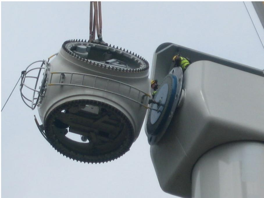
**Figura 44.** Buje de un aerogenerador siendo conectado a la góndola. Fuente: Wikimedia. Licencia: CC-BY-SA 2.0
