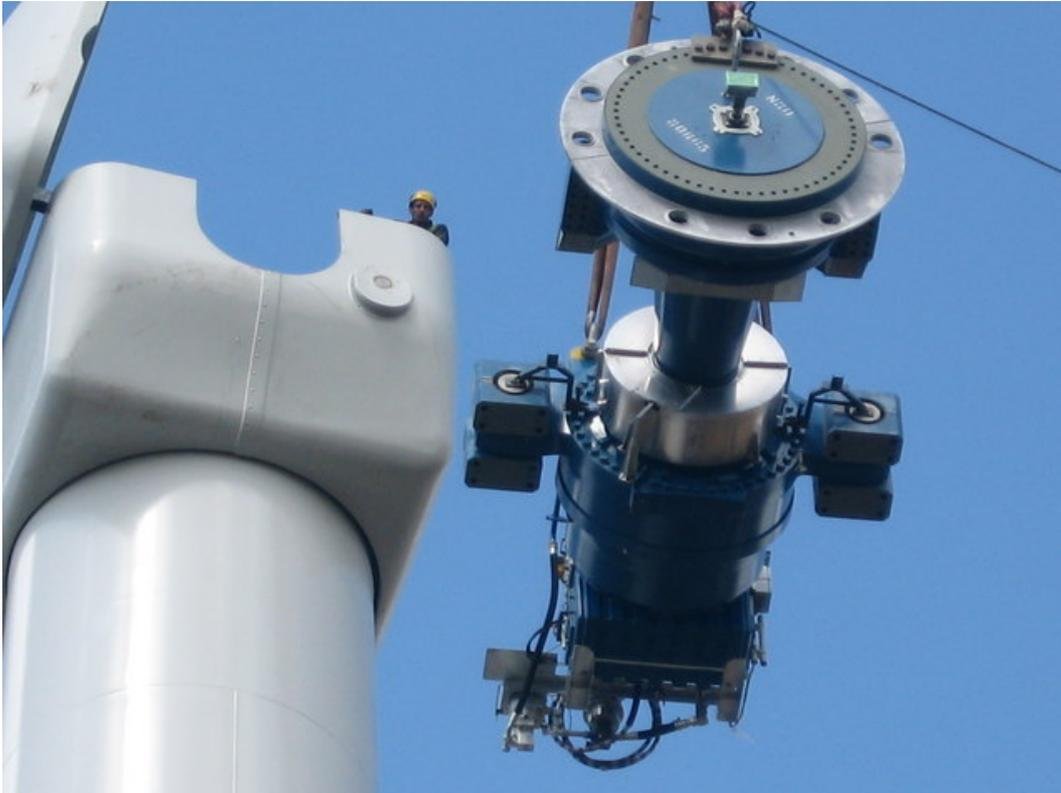
**Figura 48.** Instalación de la caja multiplicadora, eje y freno de un aerogenerador. Fuente: Wikimedia. Licencia: CC BY-SA 2.0. <http://bit.ly/2ERH8Mx>
