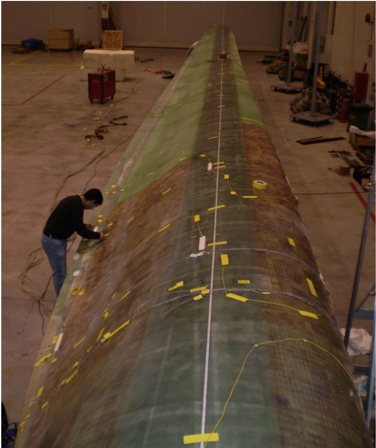
Figura 60. Imagen de la instalación de un sensor de fibra óptica en la pala de un aerogenerador. Fuente: Grupo de Ingeniería Fotónica de la Universidad de Cantabria
