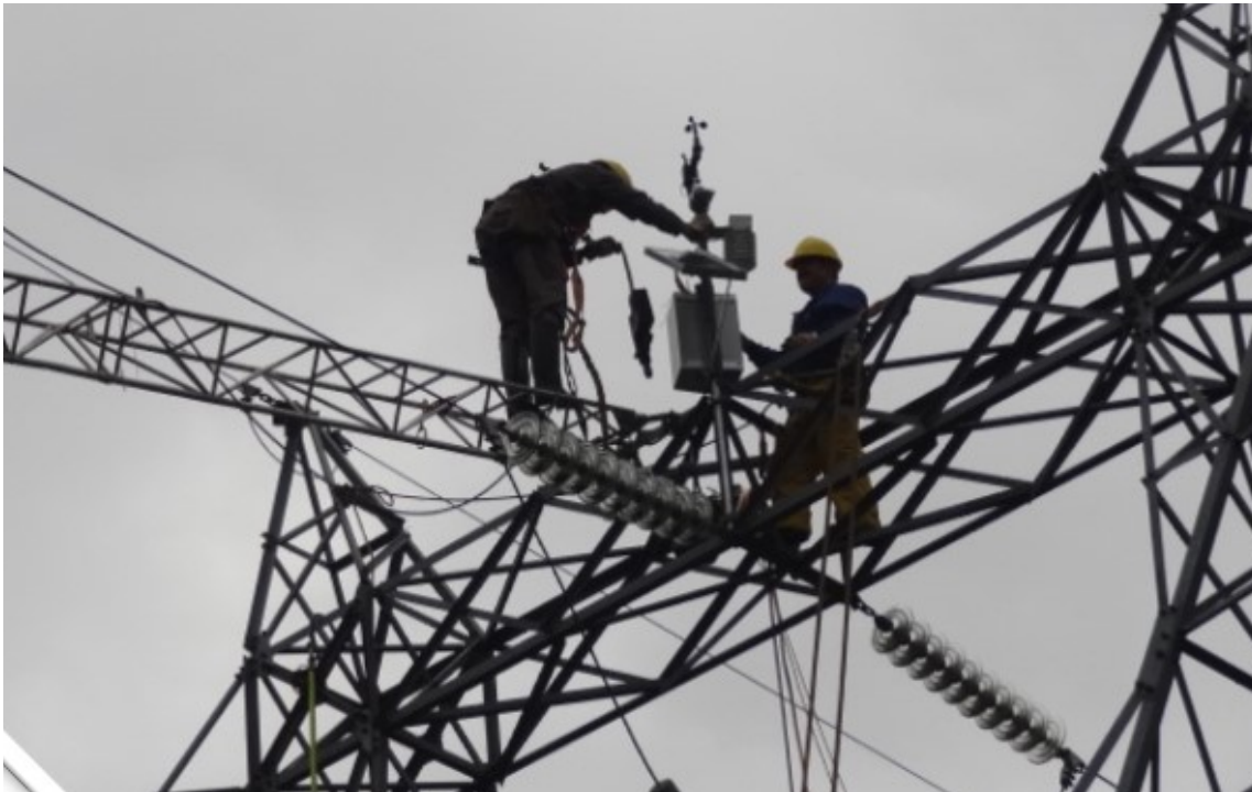
Figura 63. Imagen de la instalación de sensores meteorológicos en una línea de alta tensión. Fuente: Departamento de Ingeniería Eléctrica y Energética de la Universidad de Cantabria
