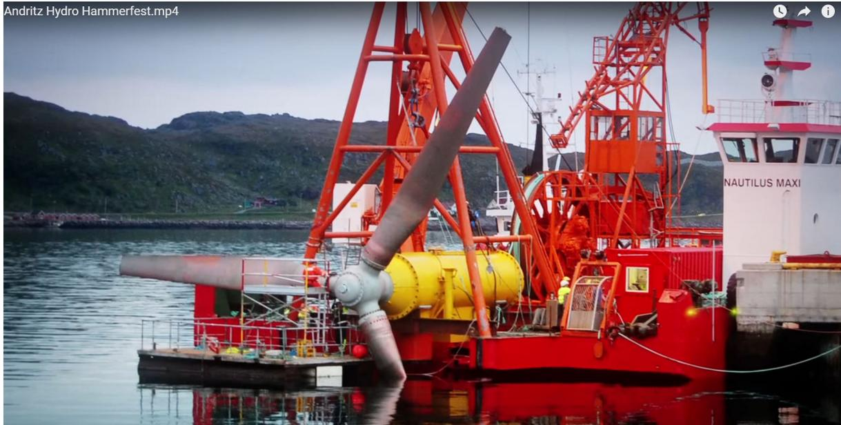
**Figura 15.** Imagen de la instalación de una turbina Lanstrom. Fuente: Imagen extraída del vídeo Andritz Hydro Hammerfest de hammerfeststrom. Licencia YouTube estándar <https://youtu.be/cHEXRbCdTck>
