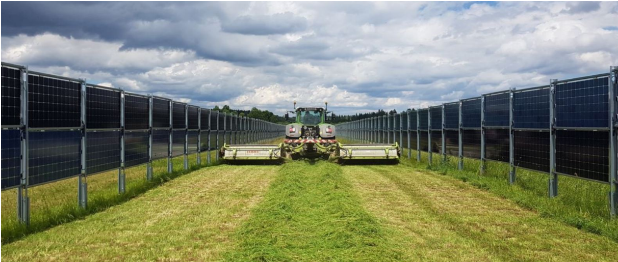
Figura 66. Imagen de una instalación fotovoltaica con paneles bifaciales dispuestos verticalmente. Fuente: Next2Sun.
