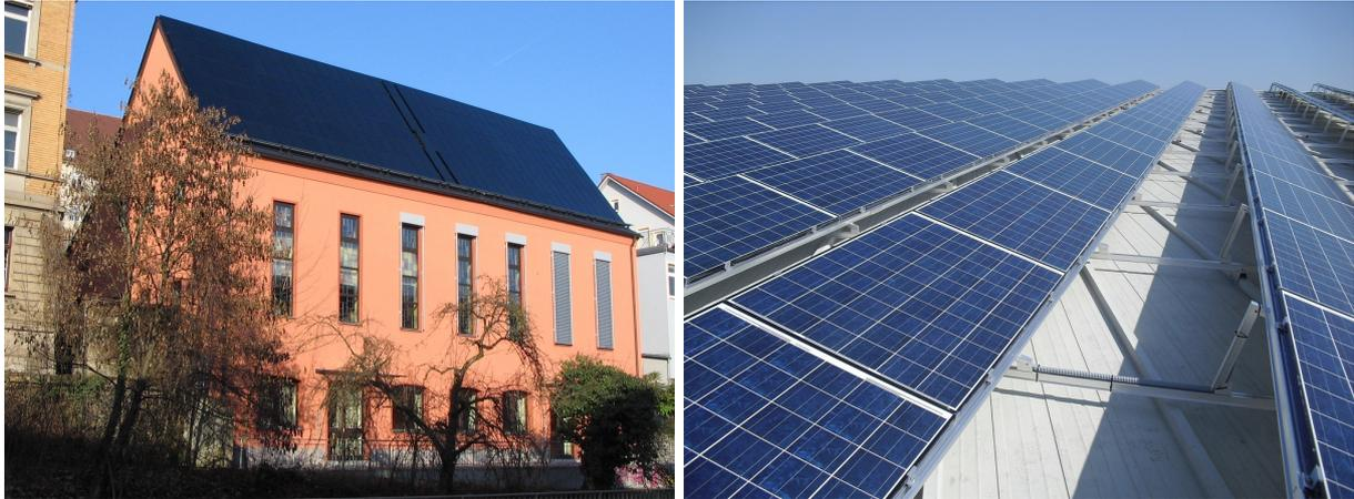
**Figura 110.** Ejemplos de instalaciones FV en tejado: (izquierda) empleando la propia inclinación del tejado; (derecha) empleando una estructura para dotar a los paneles de un ángulo de inclinación óptimo. Fuente: (izquierda) <https://bit.ly/2DgfpFH> Licencia de documentación libre GNU; (derecha) <https://bit.ly/2CPua11> Licencia CC BY 2.0
