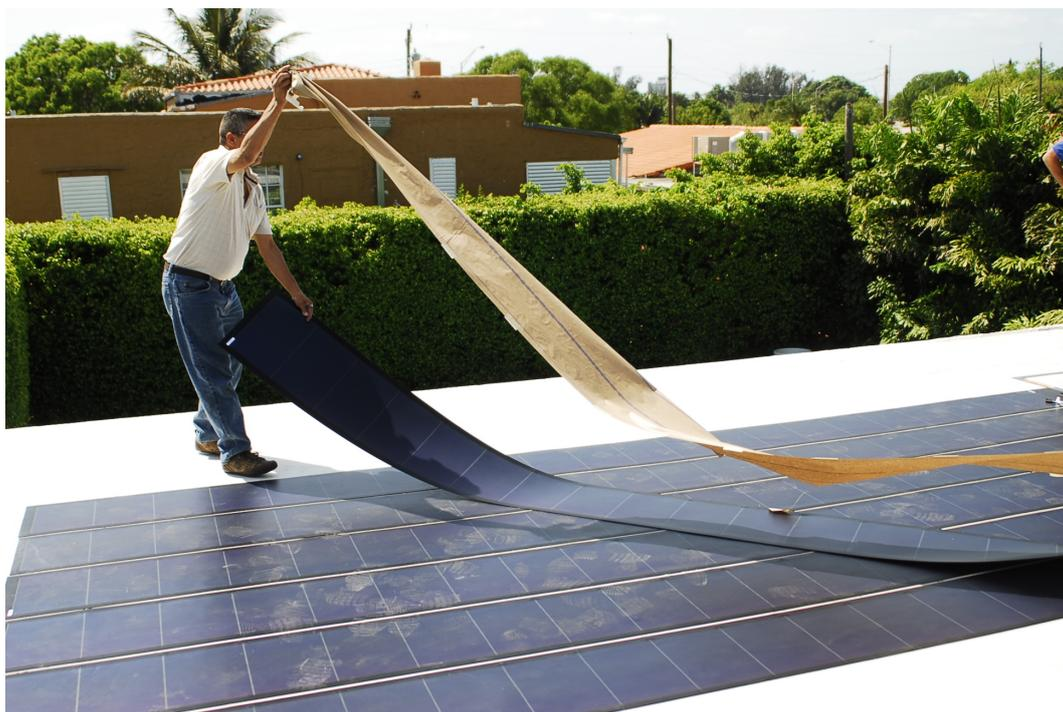
**Figura 56.** Ejemplo de instalación fotovoltaica con paneles de capa fina. Fuente: Fieldsken Ken Fields (CC BY-SA 3.0). <https://bit.ly/2lA2p1W>.
