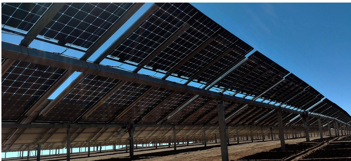
**Figura 65.** Ejemplo de instalación solar FV con módulos bifaciales. Fuente: Soltec. <https://bit.ly/2Kzy6fh>
