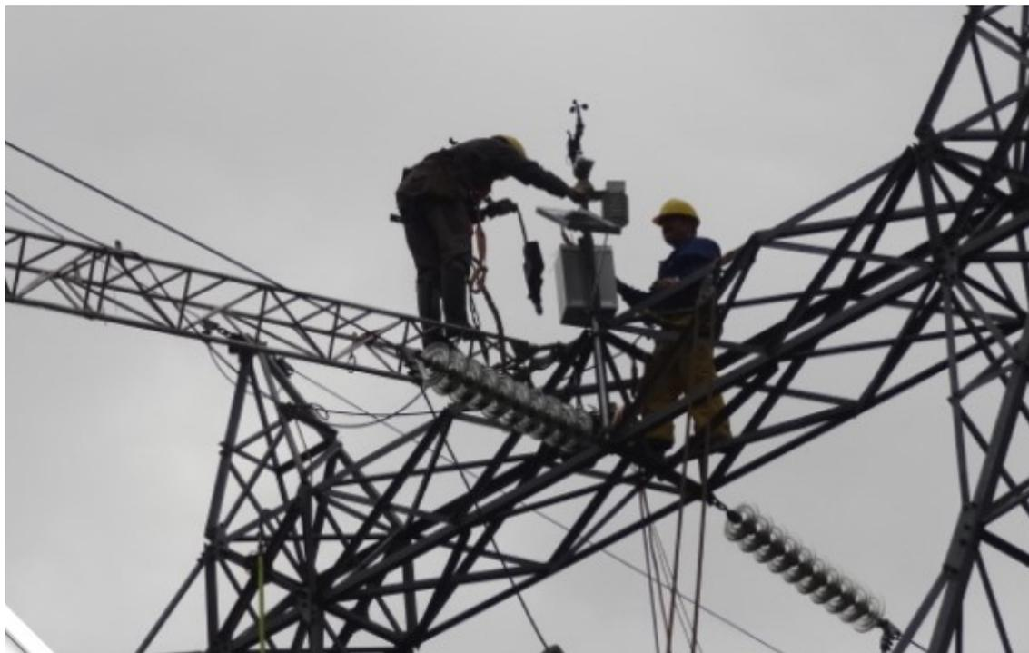
**Figura 1.62.** Imagen de la instalación de sensores meteorológicos en una línea de alta tensión. Fuente: Departamento de Ingeniería Eléctrica y Energética de la Universidad de Cantabria
