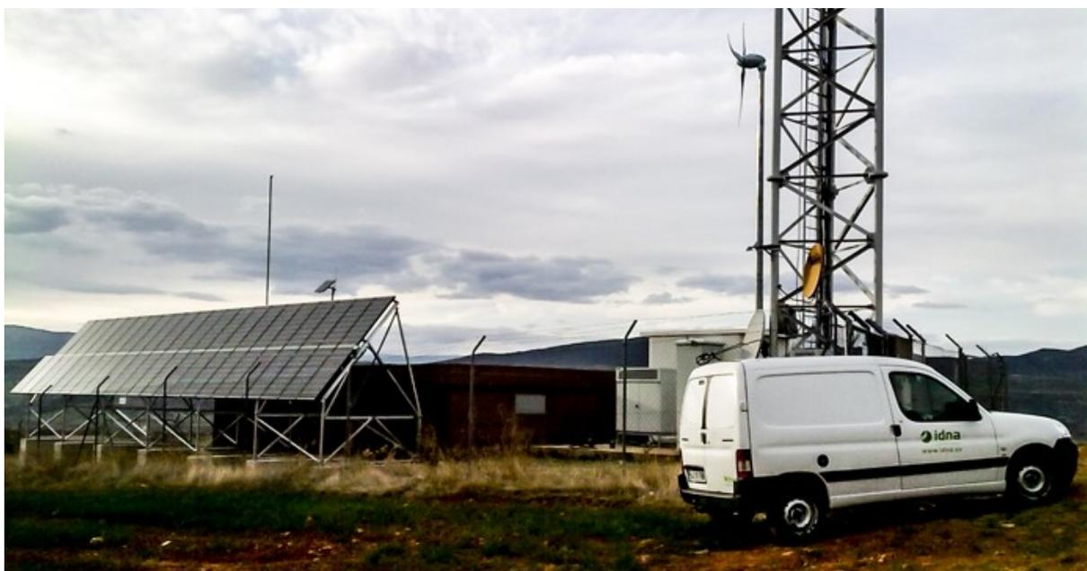
**Figura 1.53.** Ejemplo de instalación fotovoltaica y eólica vinculada a una estación TDT en Uceda (Guadalajara, España). <https://bit.ly/2AZw1ya>
