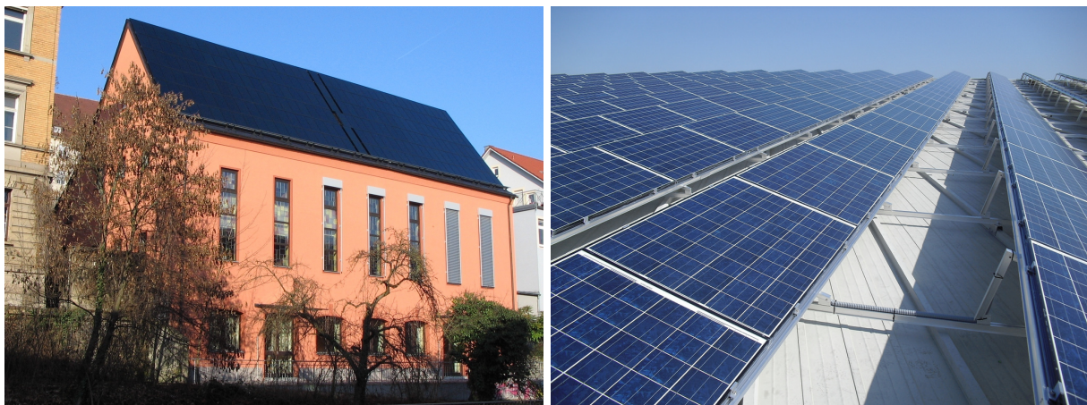
Figura 2.103. Ejemplos de instalaciones FV en tejado: (izquierda) empleando la propia inclinación del tejado; (derecha) empleando una estructura para dotar a los panles de un ángulo de inclinación óptimo. Fuente: (izquierda) https://bit.ly/2DgfpFH Licencia de documentación libre GNU; (derecha) https://bit.ly/2CPua11 Licencia CC BY 2.0
