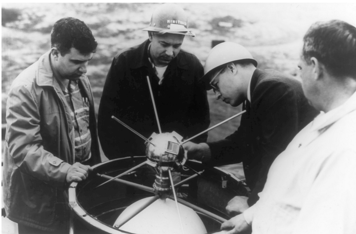
Figura 2.17. Científicos instalando el satélite Vanguard-I en el cohete de lanzamiento. Fuente: Wikimedia. License: Public Domain http://bit.ly/2DJMvBn
