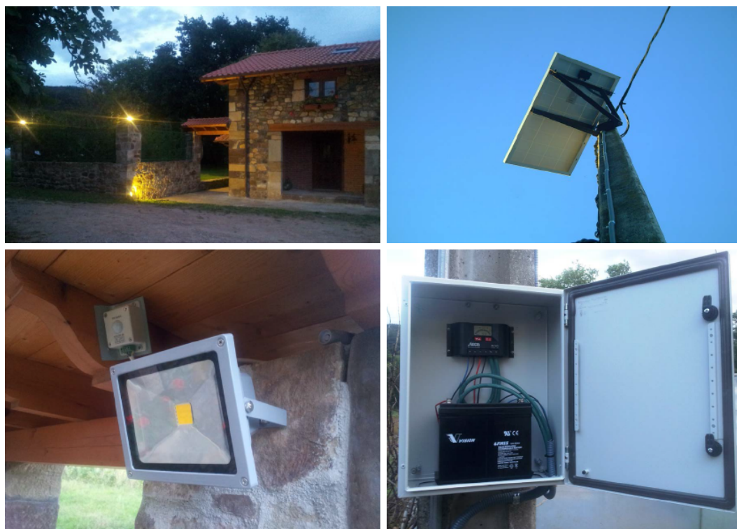
Figura 2.112. Imágenes del proyecto FV (de parte superior a inferior y de izquierda a derecha): imagen de la vivienda con el sistema FV de iluminación en funcionamiento; detalle del panel FV instalado en poste de hormigón; detalle de foco LED de 20W y detector PIR; detalle de la instalación del regulador de carga y la batería. Fuente: Instalación fotovoltaica aislada programable para alumbrado exterior con detector de presencia (David Lavín) . Licencia: Atribución-NoComercial-SinDerivadas 3.0 España.
