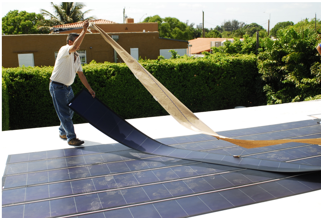
Figura 2.56. Ejemplo de instalación fotovoltaica con paneles de capa fina. Fuente: Fieldsken Ken Fields (CC BY-SA 3.0). https://bit.ly/21A2p1W .
