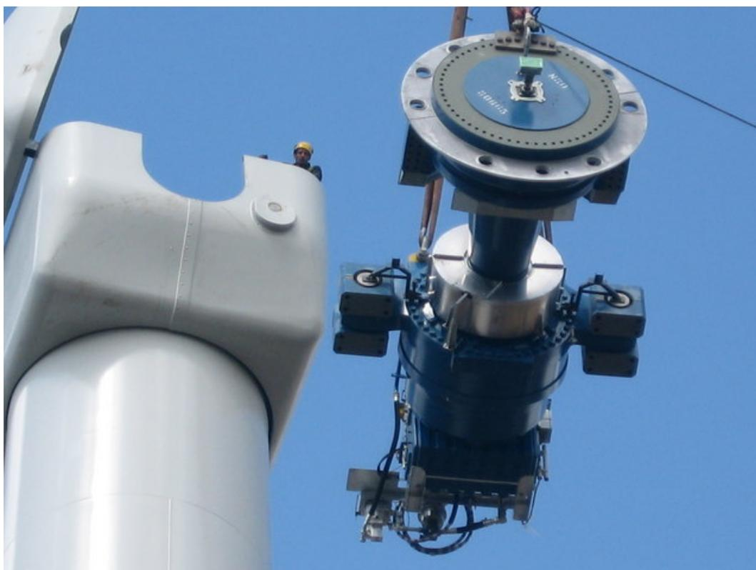
**Figura 3.40.** Instalación de la caja multiplicadora, eje y freno de un aerogenerador. Fuente: Wikimedia. Licencia: CC BY-SA 2.0. <http://bit.ly/2ERH8Mx>
