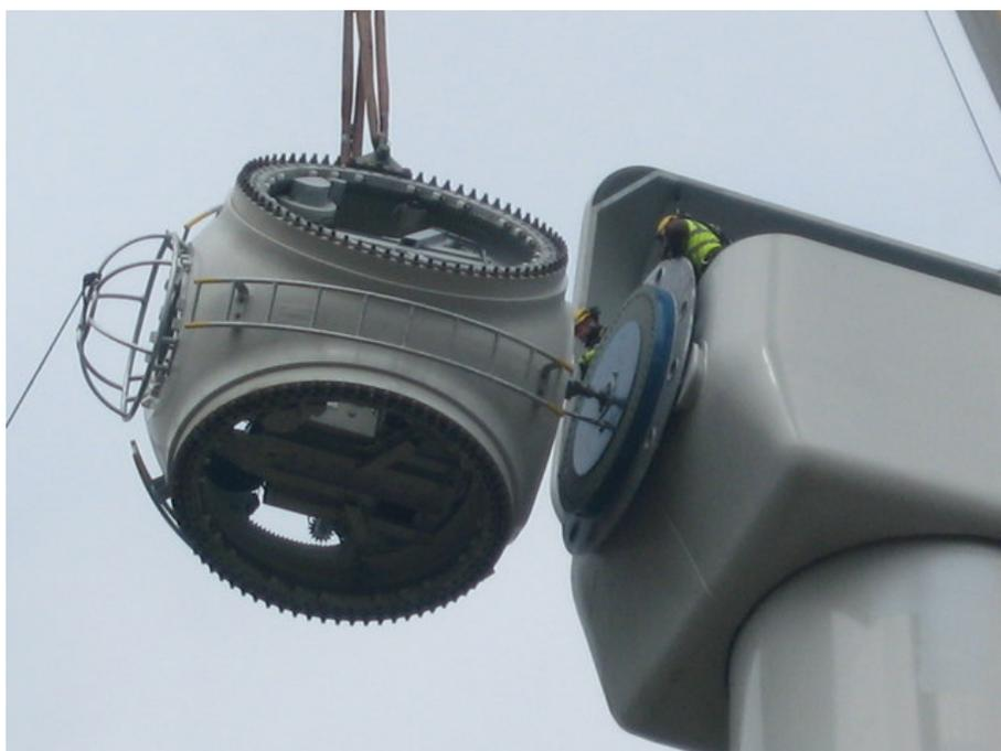
**Figura 3.36.** Buje de un aerogenerador siendo conectado a la góndola. Fuente: Wikimedia. Licencia: CC-BY-SA 2.0
