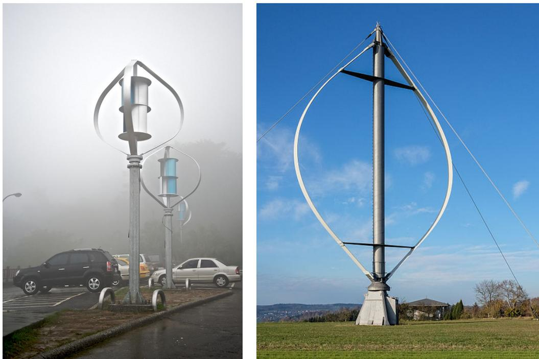
**Figura 3.3.** Ejemplos de turbinas Savonius y Darrieus: turbina eólica Savonius en Taiwan (izquierda); turbina eólica Darrieus en Baden-Württemberg (Alemania) . Fuente (izquierda): <http://bit.ly/2mG2mWV> (Licencia: CC BY-SA 3.0 (Attribution: Dietrich Krieger)); Fuente (derecha): <http://bit.ly/2mAbNXf> (Licencia: CC BY-SA 3.0 ).
