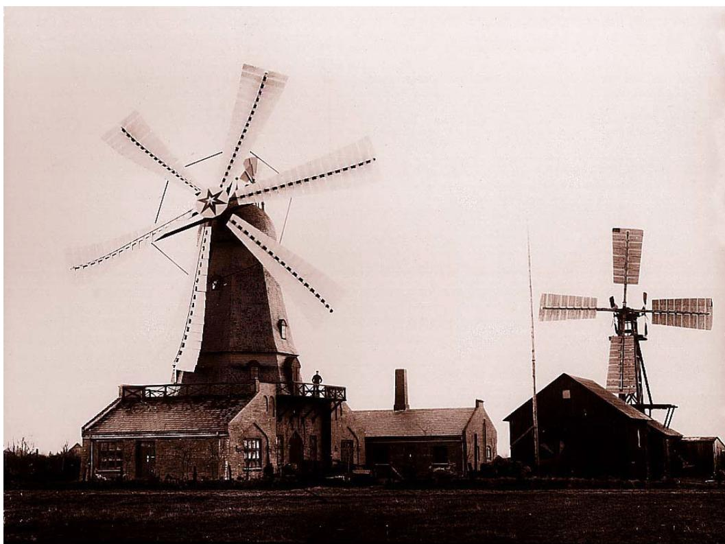
Figura 3.2. Imagen de 1897 de dos aerogeneradores de prueba de Poul la Cour en el instituto de Askov Folk, Askov (Dinamarca). Fuente: <http://bit.ly/2mFUIfm>. Licencia: © Copyright 1997-2003 Asociación danesa de la industria eólica.
