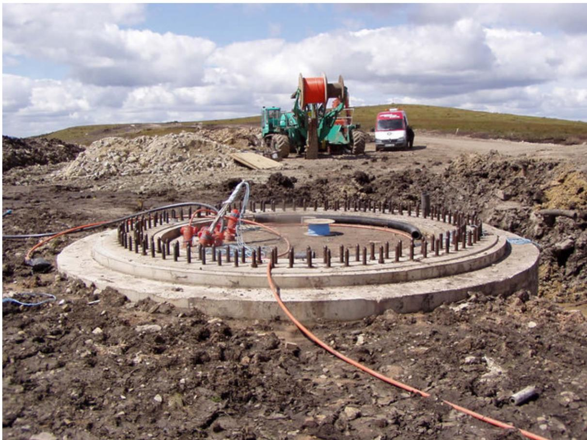
**Figura 3.30.** Cimentación de un aerogenerador *onshore*. Fuente: Wikimedia. Licencia: CC BY-SA 2.0. <http://bit.ly/2mLQ6nZ>
