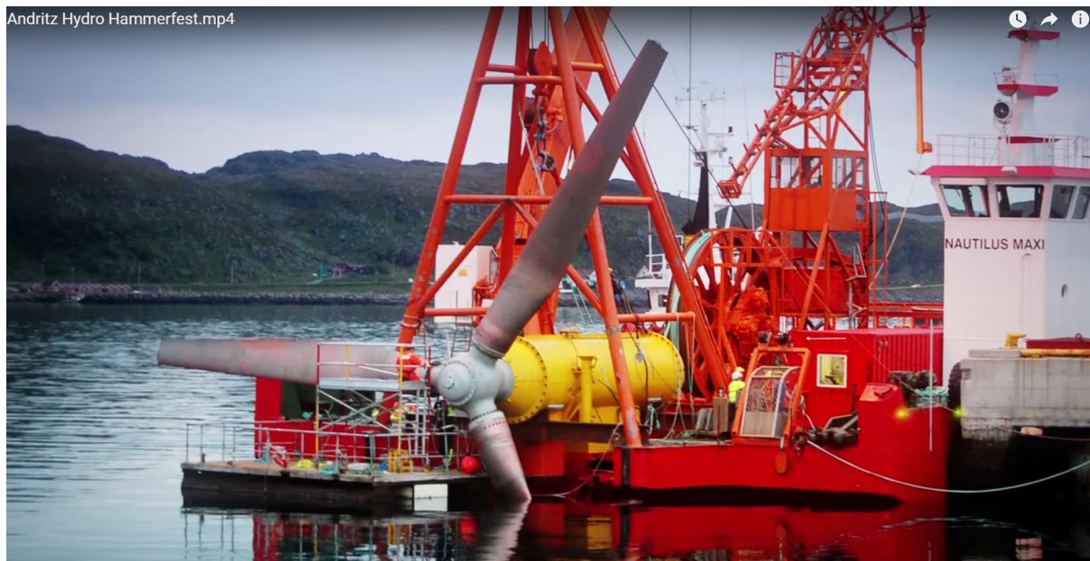
Figura 4.13. Imagen de la instalación de una turbina Lanstrom. Fuente: Imagen extraída del vídeo Andritz Hydro Hammerfest de hammerfeststrom. Licencia YouTube estándar https://youtu.be/CHExRbCdTck
