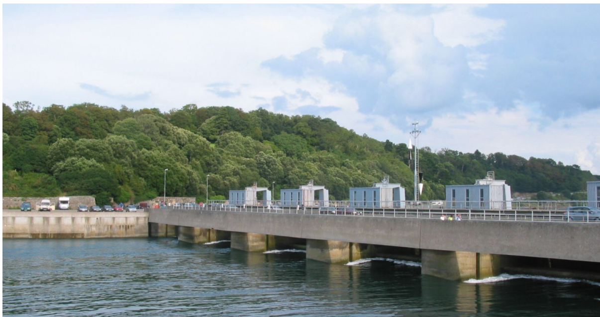
Figura 4.12. Imagen de la central eléctrica mareomotriz en el estuario del río Rance. Fuente : Wikimedia / Dani 7C3. License: CC BY-2.5 http://bit.ly/1GLZQ8g
