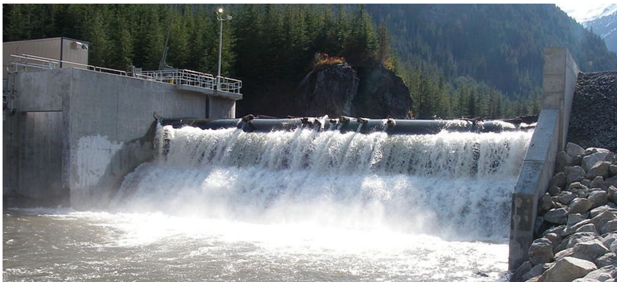
Figura 4.1. Ejemplo de planta hidroeléctrica en el curso de un río en Toba Montrose. Fuente: Altterpower. Licencia CC BY-SA 3.0. https://bit.ly/2GaTnN
