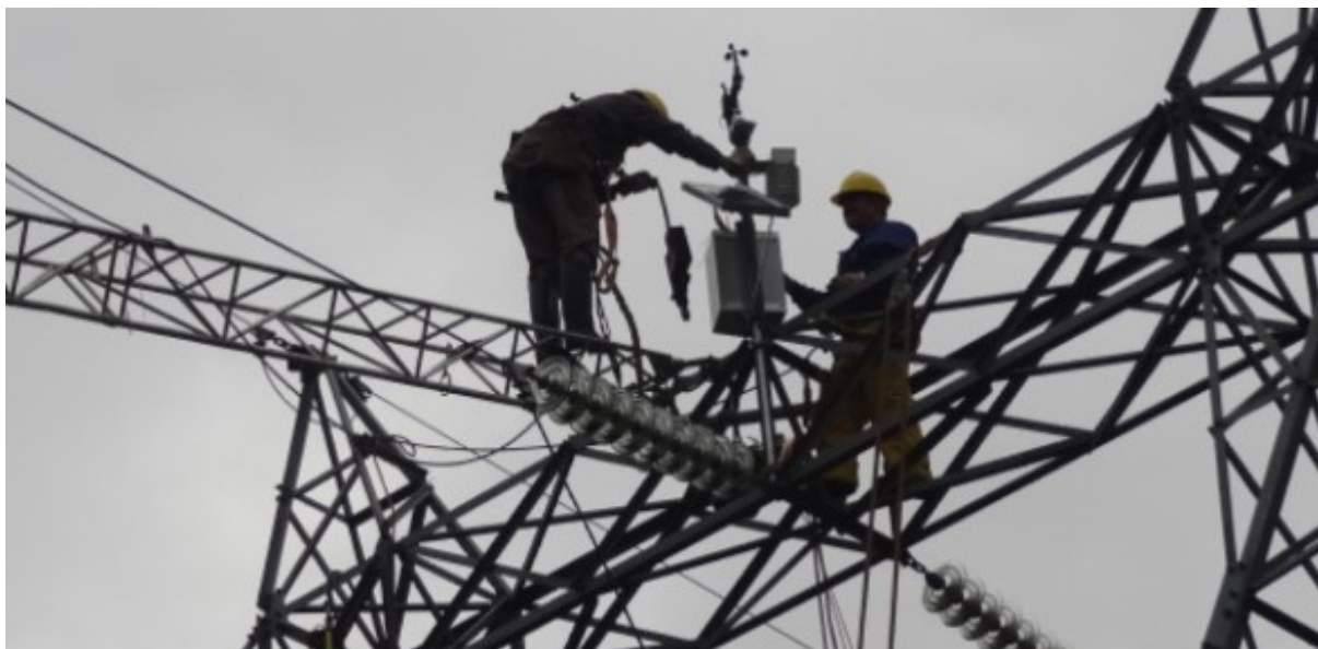
Figure 1.63. Weather sensors being installed in a power line. Source: Departamento de Ingeniería Eléctrica y Energética de la Universidad de Cantabria
