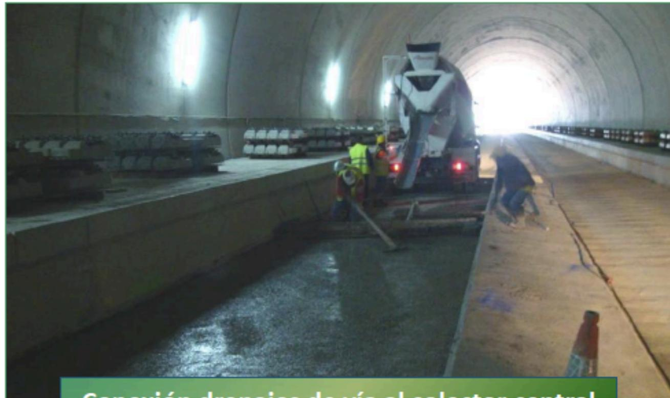
Conexión drenajes de vía al colector central
