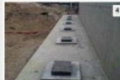
Neoprenos colocados sobre mortero de nivelación
