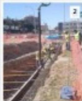
Hormigonado y vibrado de viga cargadero
