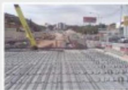
Prelosas y ferralla sobre vigas prefabricadas
