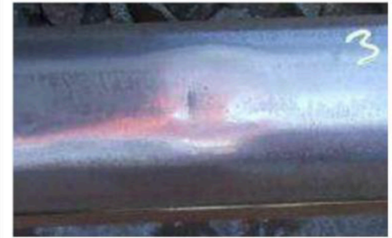
010502 Aplastamiento de la superficie de rodadura moderado [40]
