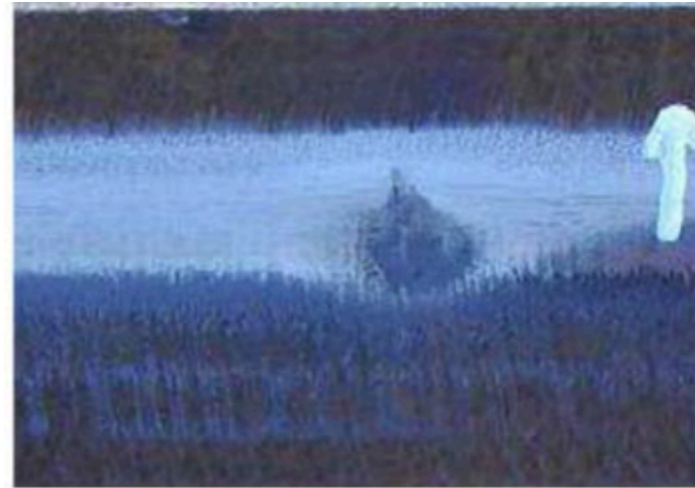
010501 Aplastamiento de la superficie de rodadura leve [10]
