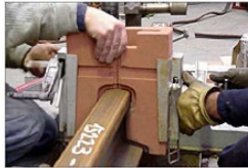
Colocación de los moldes
