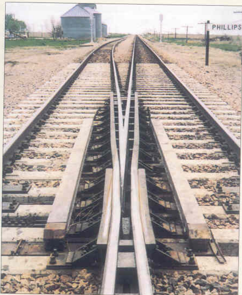
VISTA GENERAL DE UN CRUZAMIENTO DE CORAZÓN MÓVIL
